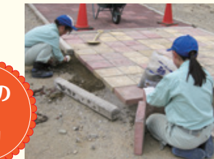
通学路舗装実習
